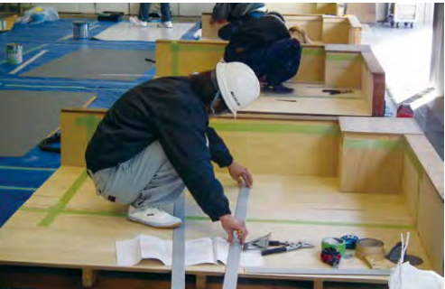
施工講習会の様子
