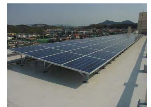
太陽光パネル設置工法による設置
