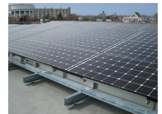
太陽光パネル設置工法による設置
