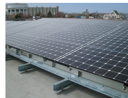
太陽光パネル設置工法による設置
