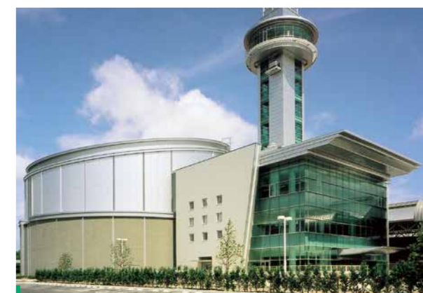
芦屋競艇場施設 ＜福岡県＞
