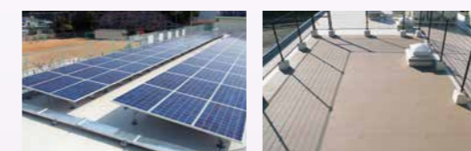
太陽光パネル
