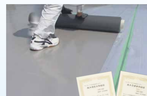
シート防水施工風景
