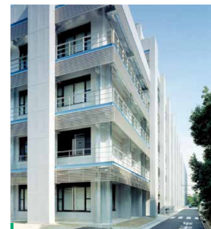
大阪大学基礎工学部本館 ＜大阪府＞
