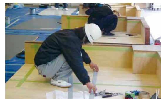
施工台を使用している施工指導
