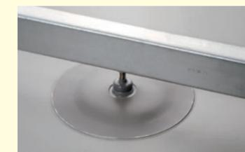
防水層とは溶剤溶着または、熱風融着で接合。強力な水密性を発揮します。
