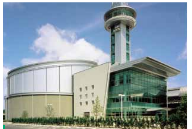
芦屋競艇場施設 <福岡県>
