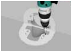
⑥防水層押えの固定
