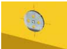
①位置決めプレートを型枠に取り付け
