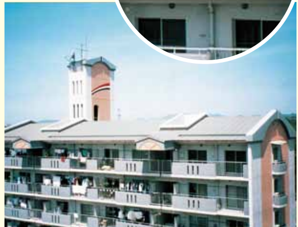
ロンライン施工例
