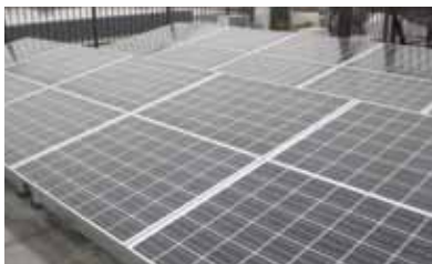
太陽光パネル設置工法の施工例
