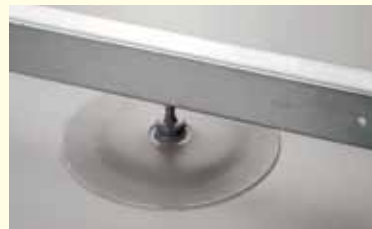
防水層とは溶剤溶着または、熱融着で接合。強力な水密性を発揮します。
