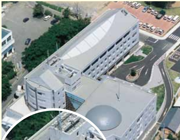
ロンライン施工例
