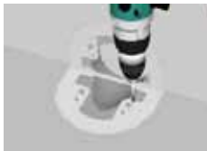
⑥防水層押えの固定
