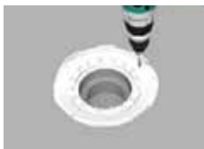
⑥防水層押えの固定
