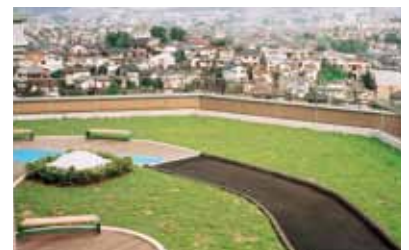
屋上緑化(ロンググリーン仕様)の施工例
