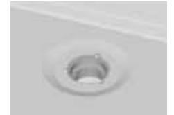
⑤防水シートの敷き込み・溶融着
