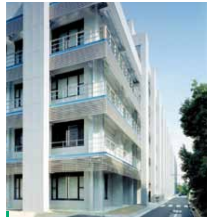
大阪大学基礎工学部本館 <大阪府>
