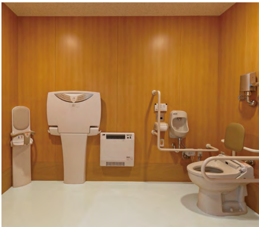
施工写真 SAC-2042
