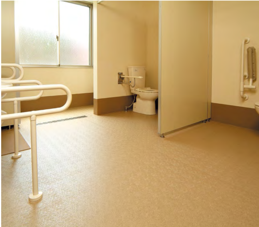
施工写真 TN-4004
