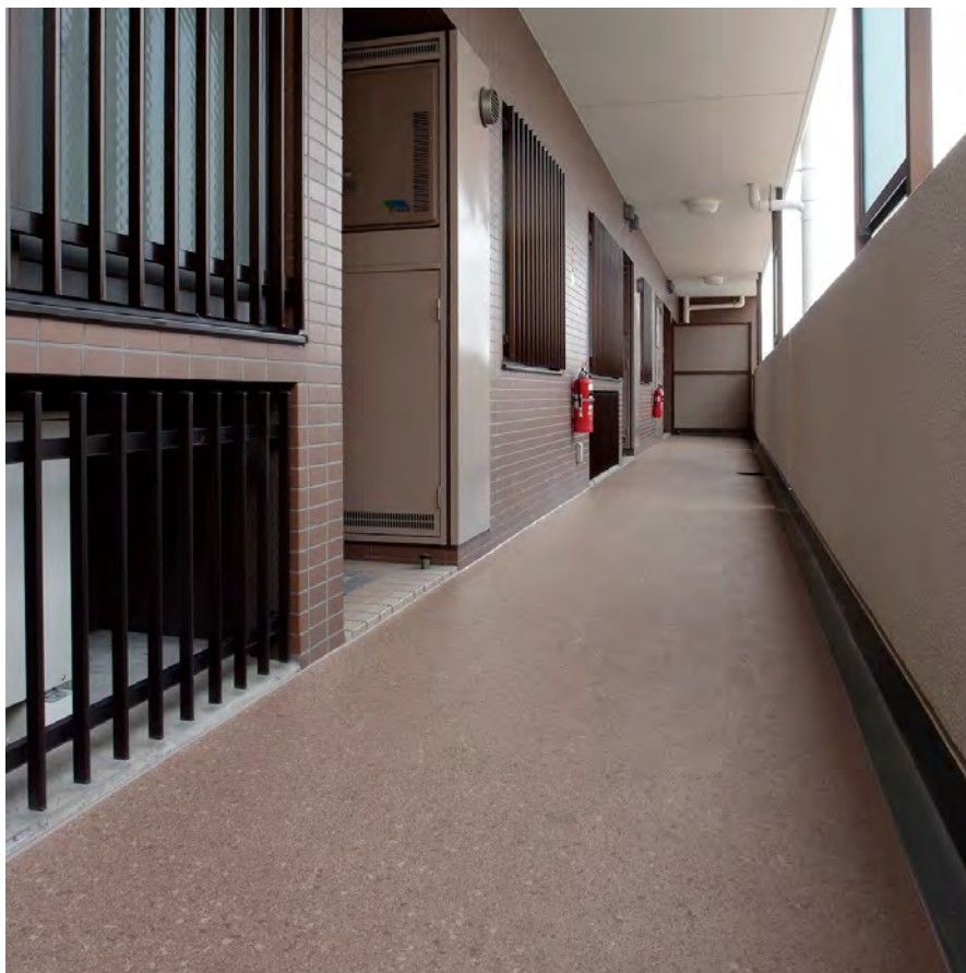
施工写真 AT-403
