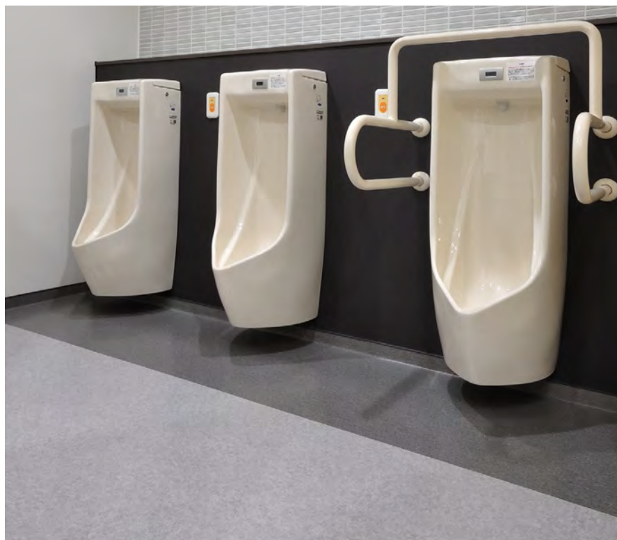
施工写真 SL-122・SL-202
