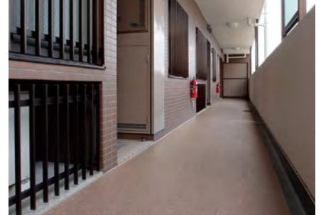
パセラット 施工写真 AT-403
