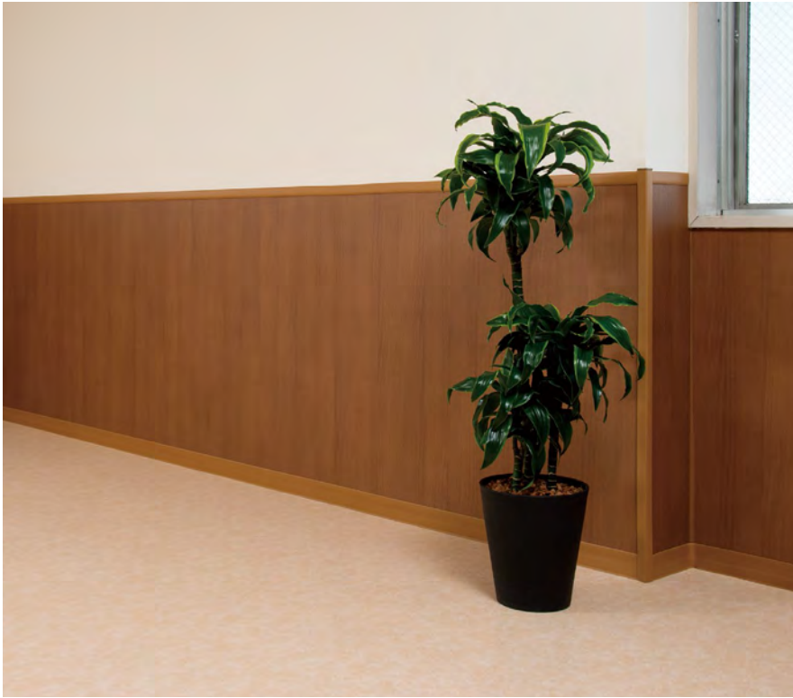
施工写真 GL-353
