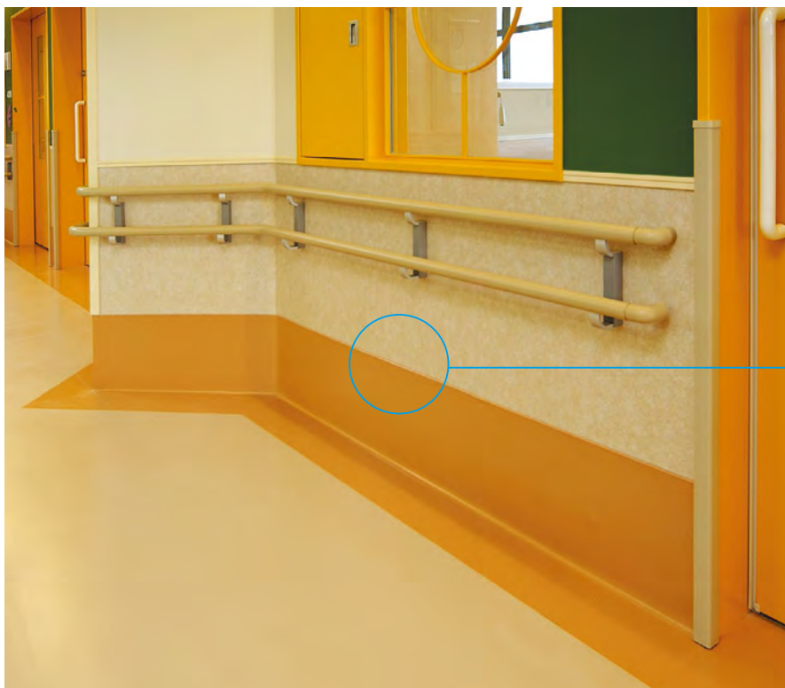
施工写真 ロンリウムブレン3407に取付
