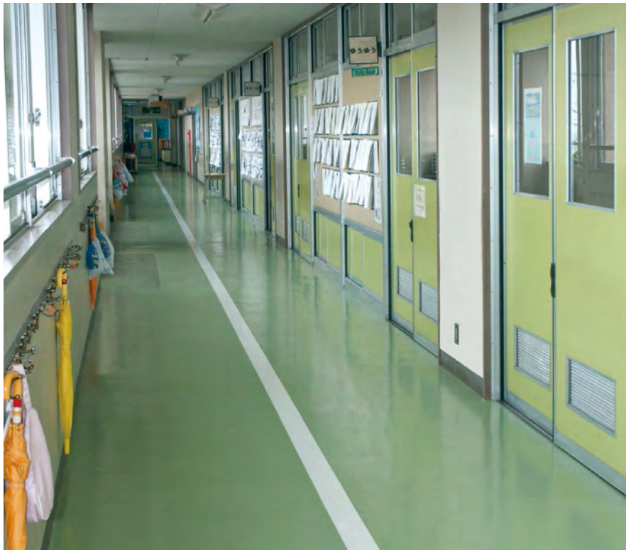
施工写真 ロンリウムプレーン 3138 X ホワイト
