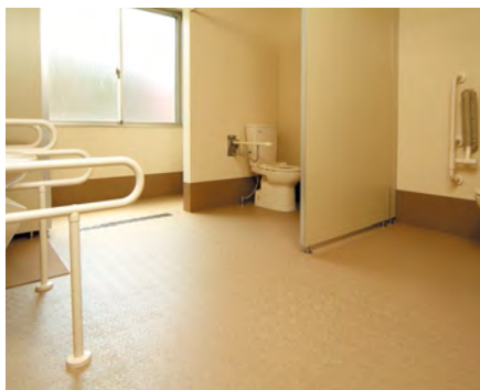
チェルニー 施工写真 TN-4004
