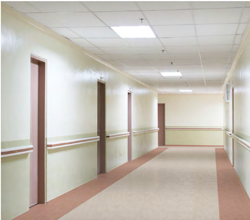
施工写真 PRB-102・PRB-114
