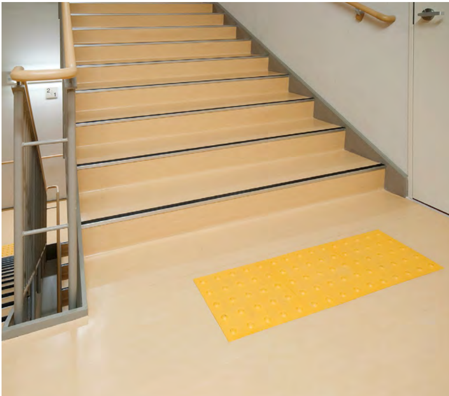
施工写真 20STA-111
