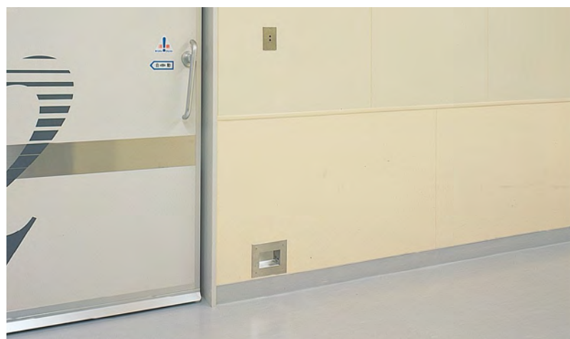
施工写真 ロンリウムSRG SRG-5902に取付
