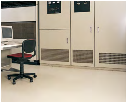
プレーン 施工写真 OA-5
