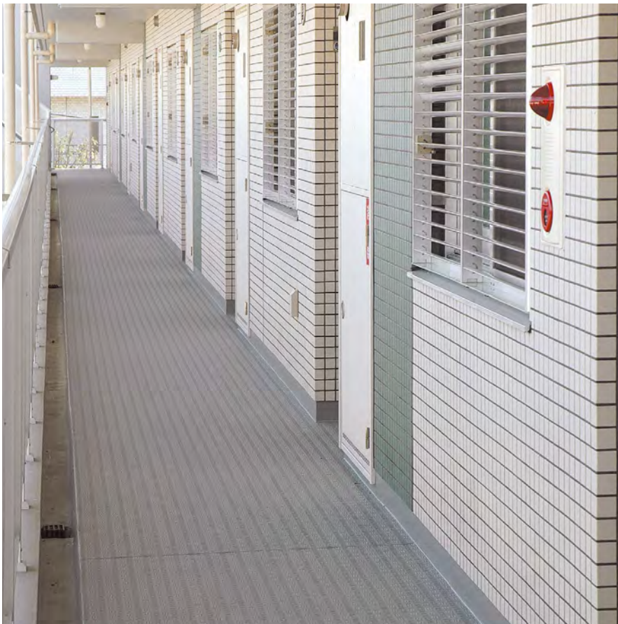
施工写真 JP-13
