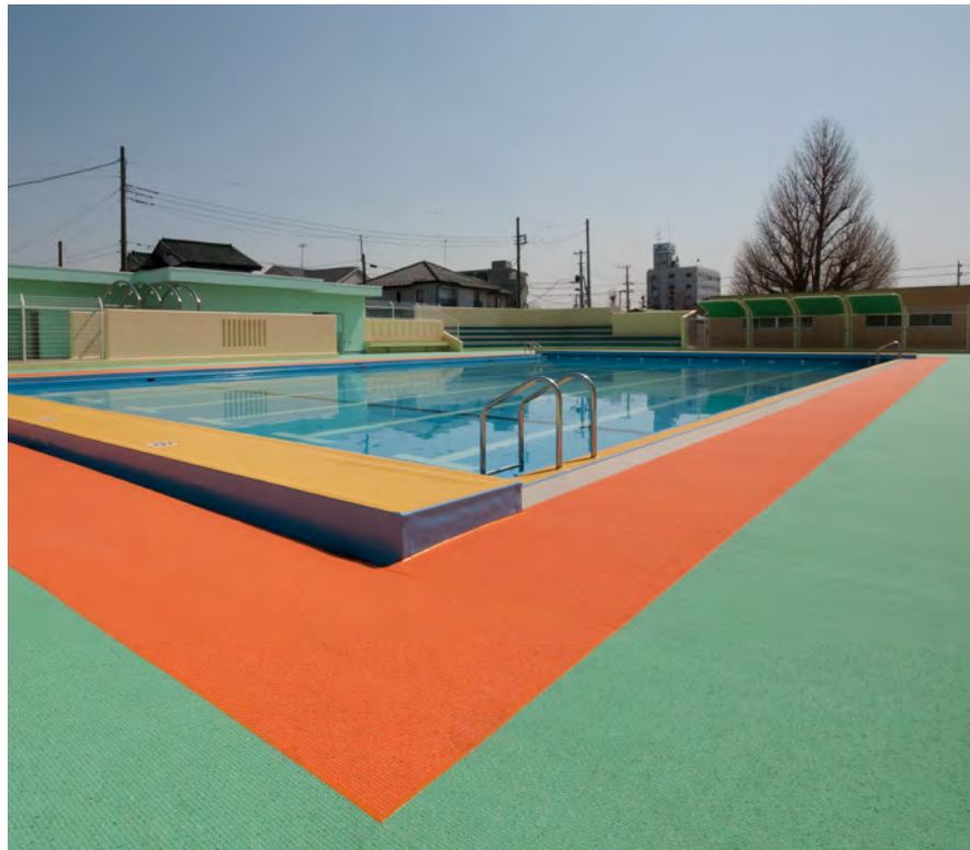
施工写真 RHS-301・RHS-308
