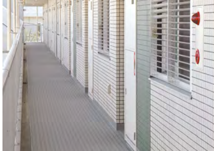
ジャスパー 施工写真 JP-13
