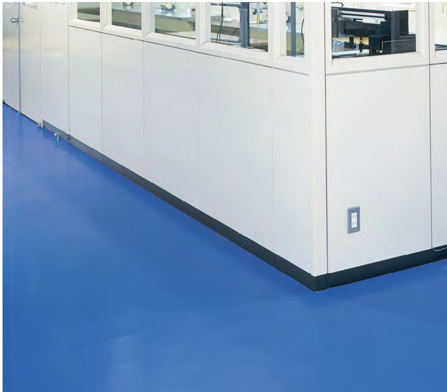
施工写真 CD-602
